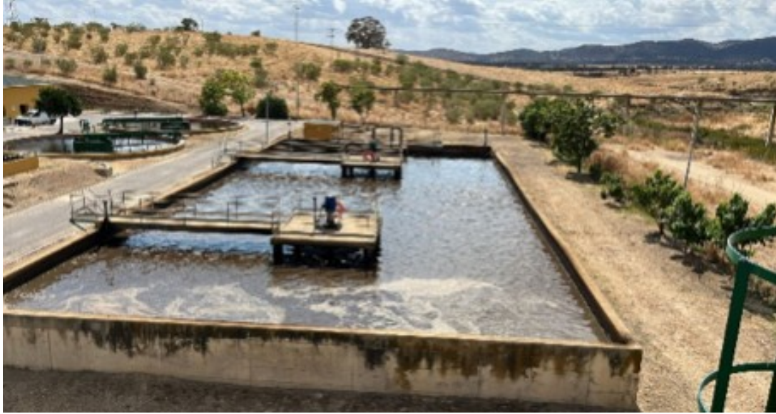
EDAR PEÑARROYA - PUEBLONUEVO
