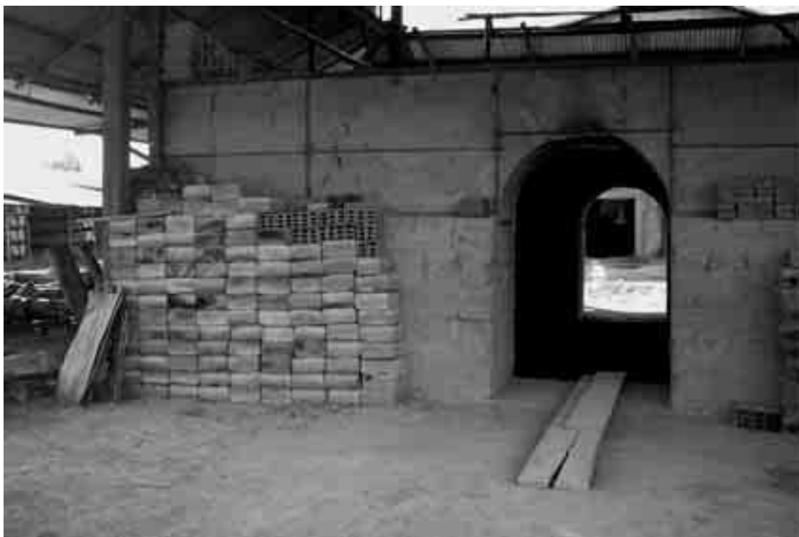
Horno de la nave.
