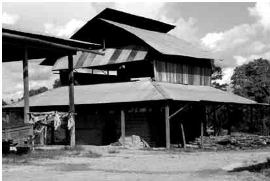
Secadero externo de ladrillos.
