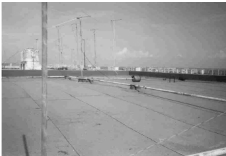
Techo impermeabilizado Viviendas Alamar-Habana Este (La Habana). 2001
