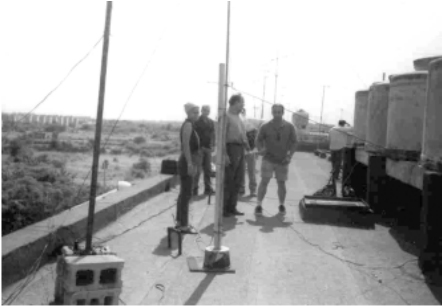
Techo de vivienda impermeabilizada en Almar
