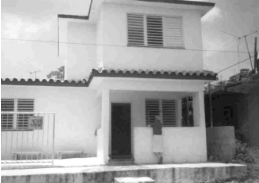
Vivienda del Municipio 10 de Octubre
