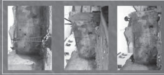
Retirada de la antigua estructura
