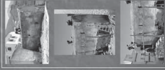
Colocación de la losa de ladrillos tradicionales y cobertura en hormigón
