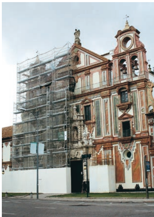
Foto 2. Casa Palacio de La Merced. Fachada Actual.
