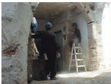
Foto 2. Imagen antes de la restauración.
