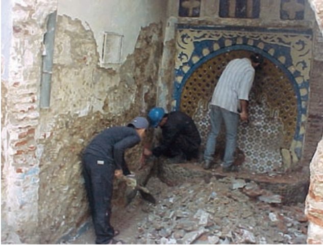
Foto 4. Restauración de fuente.
